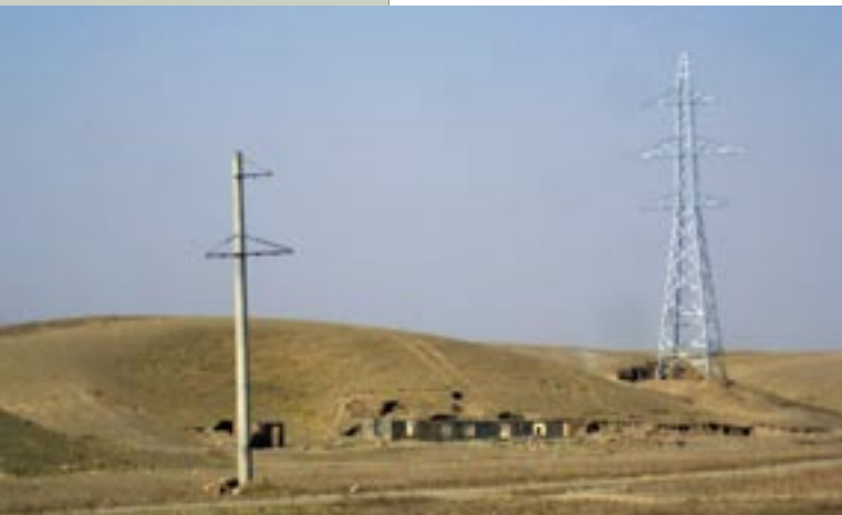
Photo ci-dessus : Province de Takhar : les gaspillages de l'aide dans le projet d'électrification de Kaboul depuis l'Ouzbekistan. À gauche, un poteau prévu pour 110 000 V, remplacé par un pylône transportant 220 000 V avant même sa mise en fonctionnement. (© URD)
